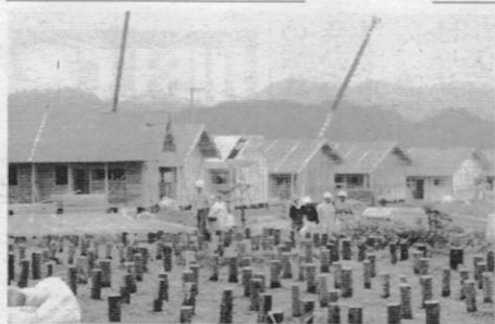
板倉構造で建設中の仮設住宅
