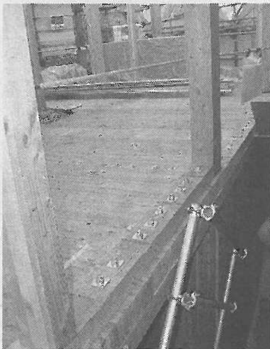
施工中の現場。床に杉と米松の120ミリのマッシュホルツを2層、直交して使用している
